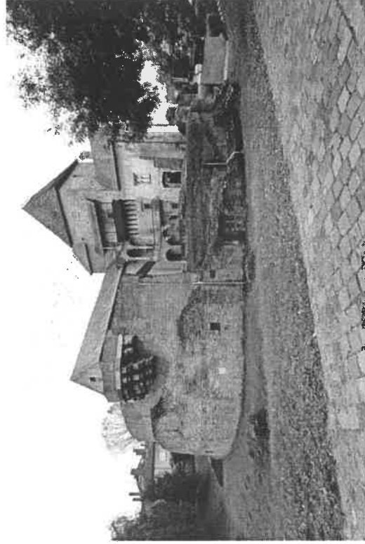
Északnyugat felől a várudvar metszetben látszik hangsúlyosan megmutatva a 70-es évek műemléki helyreállításának eredményeit. A határoló várfalak felületén jól látszanak a vízelvezetési problémák okozta meghibásodások. A vár fölött tekintélyes galambcsapat köröz, mely sok gondot okoz a vármúzeum fenntartásában.
