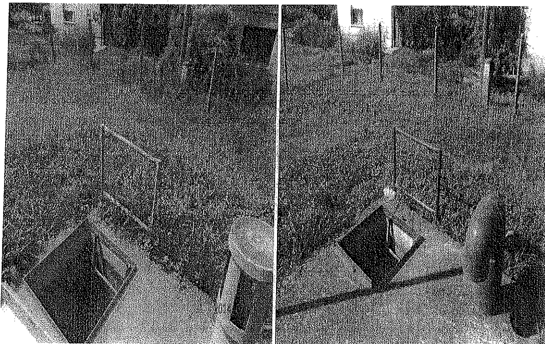
Laposi tér VI. sz. kút akna szellőzés átalakítása „pipás” kivitelre fém szúnyoghálóval
