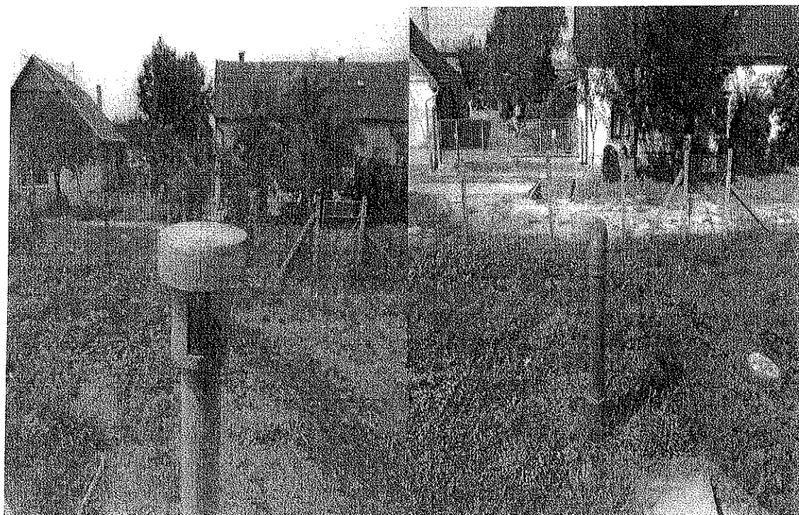
medence szellőzők átalakítása
